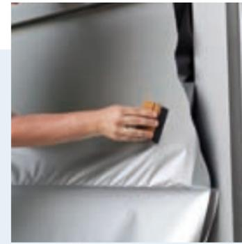
Nach der Vorbereitung der Oberflächen, wird der vorgeschnittene PVF-Film direkt auf die bestehenden Flächen appliziert. Eine Demontage der Fassadenelemente ist nicht erforderlich. Das geringe Gewicht der Folie ermöglicht dabei eine optische Erneuerung in nahezu sämtlichen Bereichen der Fassade – ohne Eingriff in die Statik.
